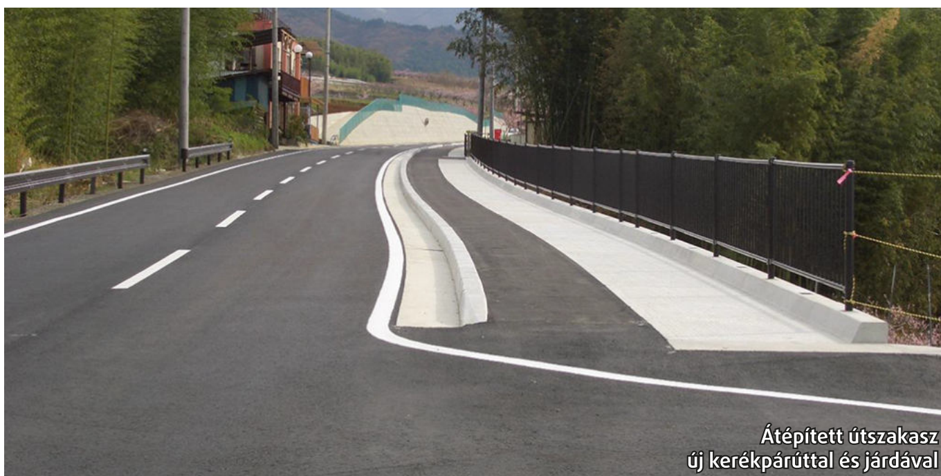
Konzolos támfalas közlekedési elemek beépítése
