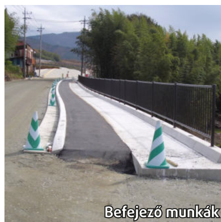
Konzolos támfalas közlekedési elemek beépítése
